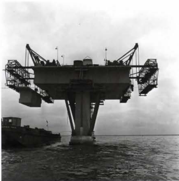
Een van de tien pijlers in aanbouw. Bron: Beeldbank Rijkswaterstaat
