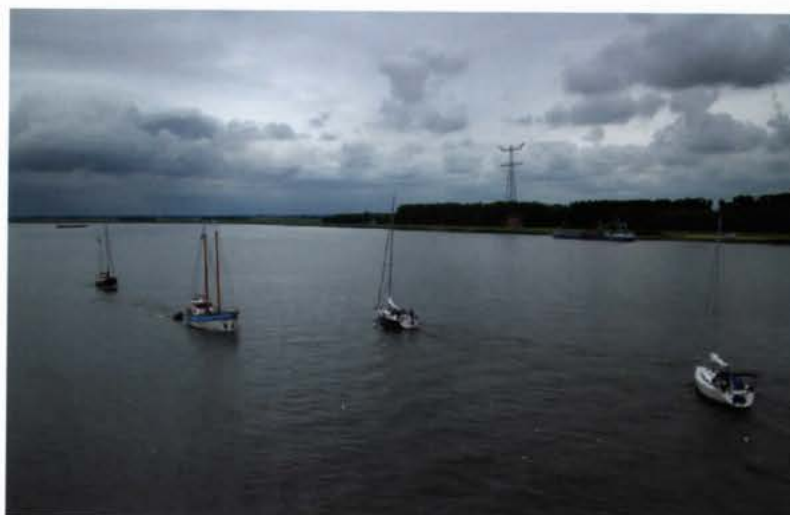
Het Ketelmeer met zeiljachten die wachten tot de boten vanaf het IJsselmeer de brugopening gepasseerd zijn. De 18 m brede doorvaartopening kent eenrichtingverkeer.
