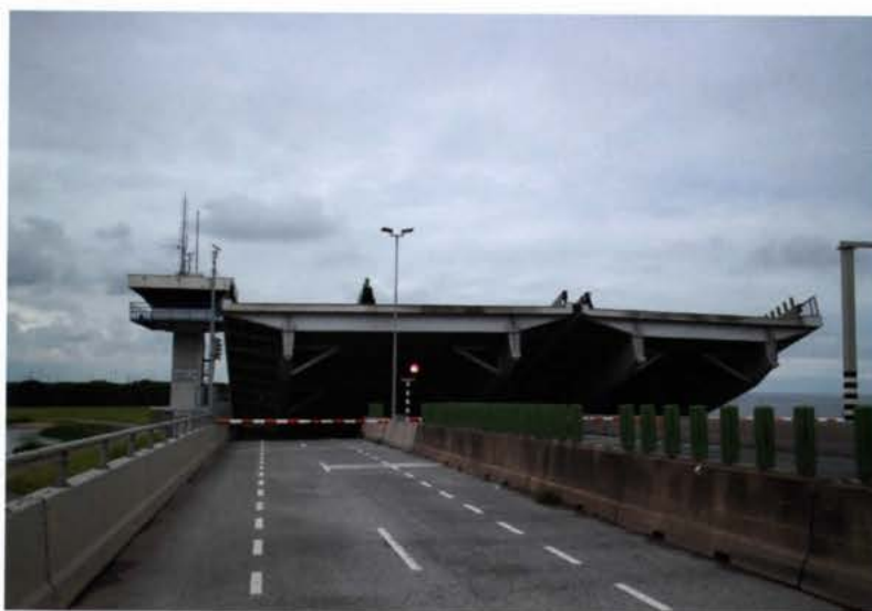
Over de 32,5 meter brede brug ligt aan de oostzijde ook een parallelweg voor langzaam en lokaal verkeer. Dat heeft er toe geleid dat de twee brugklappen een ongelijke breedte hebben.
